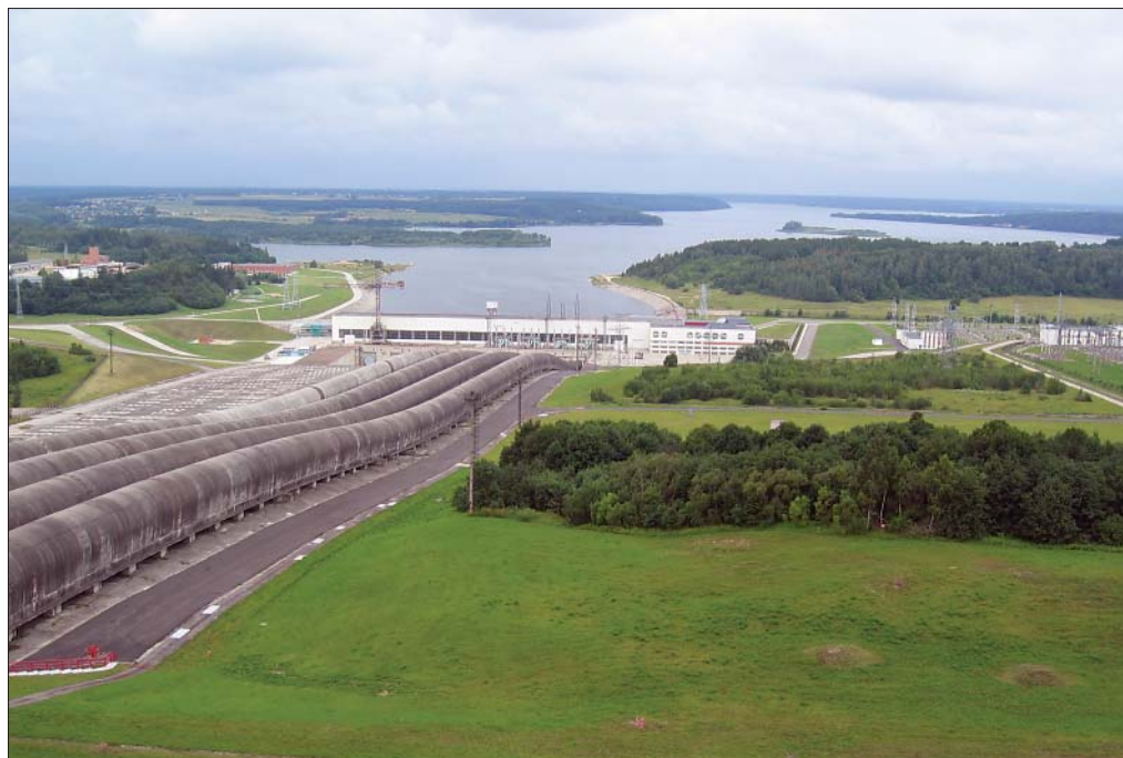
Pumpelagerkraftværk ved Kruonis i Litauen – et eksempel på lagring af energi ved hjælp af vand og en højdeforskel på ca. 100 m. De store rør leder vandet ned til eller op fra turbin/pumpehallen. Den maksimale effekt er 900 MW og reservoirsoen har et areal på 3 km 2 .
