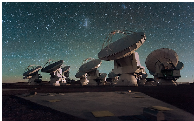
ALMA-teleskopet i Atacama-ørkenen i Chile består samlet af 66 antenner som dem på billedet, der kan benyttes som et samlet teleskop eller i mindre grupper. Foto: ESO/C. Malin
