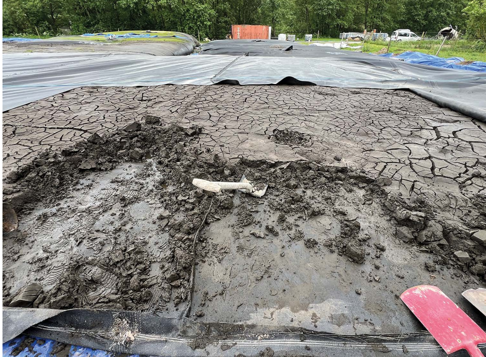
Ved Ormstrup sø ligger de store aflange afvandingsposer (geotubes), hvor det våde sediment pumpes op i poserne. Vandet løber ud af poserne, samles op af presenningen under poserne, hvor det bliver ledt hen igennem et sandfilter og tilbage til søen. På billedet vises en afvandingspose, hvor sedimentet er afvandet. Posen er skåret op, og sedimentet er klar til at blive fragtet videre. Foto: Kasper Reitzel.
