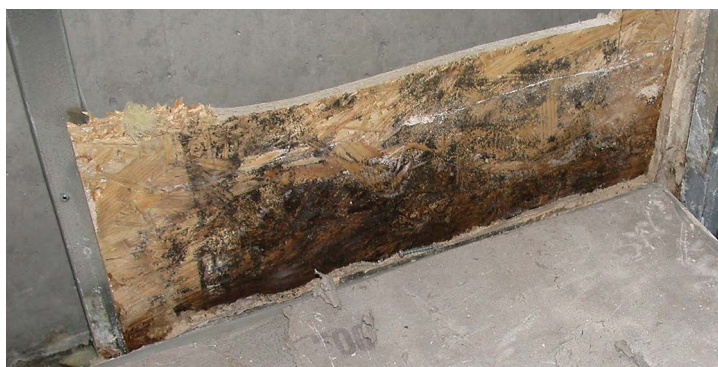
Chaetomium globosum , der vokser på en OSB-plade. På ydersiden har der siddet en gipsplade, og skimmelsvampen har vokset inde i vægkonstruktionen mellem de to plader. Begge plader har suget vand op på grund af en fejlkonstruktion. Foto: Birgitte Andersen
