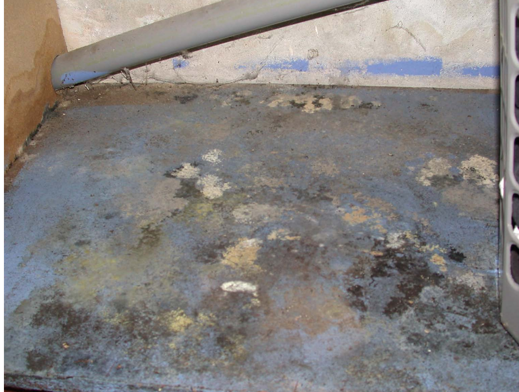
En meget inficeret spånplade i bunden af et vaskeskab i en kælder. Kælderen blev oversvømmet under det store skybrud i 2011 i København. Den blåmalede bundplade viser vækst af Aspergillus spp., Chaetomium spp., Penicillium spp. og Ulocladium spp.
