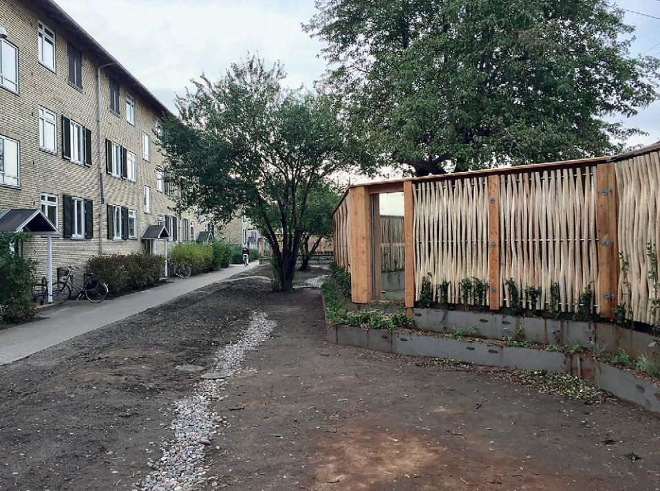
Princip for LAR-anlæg i Folehaven, hvor vandets potentielle energi fra taget bruges til at løfte vandet op i fordelerrenden i toppen af den grønne klimaskærm (ovenfor). På fotoet ses klimaskærmen i forbindelse med indvielsen i efteråret 2019. Kilde: Marina Bergen Jensen, Københavns Universitet.
