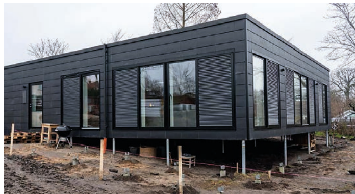
Typehus med skruefundament. Foto: Holm Huse
