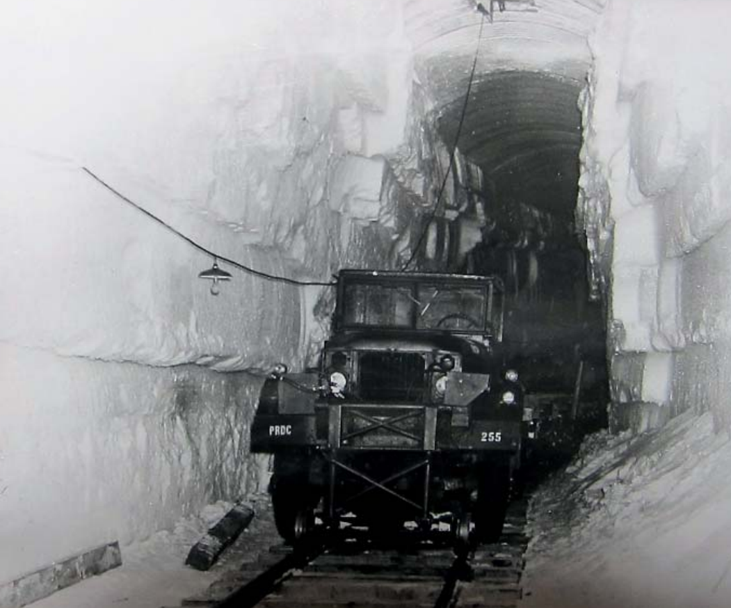
Forsøg med skinnebaseret transport foregik i en speciel Camp Century-tunnel i årene 1961-64. Foto: US Army.
