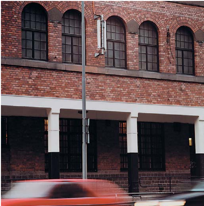
Eksempel på en "3G"-antenne på en husfade i den indre by.
