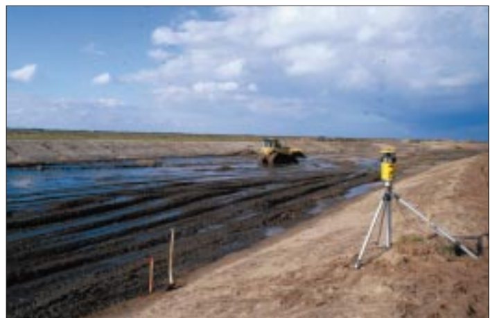
Den sidste affrudning af løbet er et laserstyret præcisionsarbejde.
